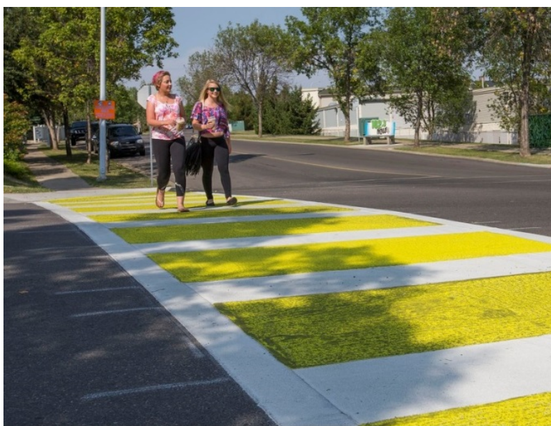
Рис. 6. Приклад експериментального дослідження варіанту флуоресцентного переходу
